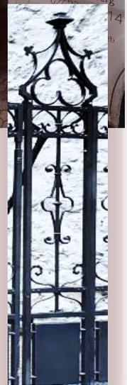
Zur Aufarbeitung der Schäden mussten die Torelemente abgeflext und zum Fachbetrieb Bougé abtransportiert werden. Die aufwendigen Reparaturen und Aufarbeitungen an der schmiedeeisernen Toranlage – Durchgang von der Salmstraße zum Jordanplatz - sind nun abgeschlossen.
